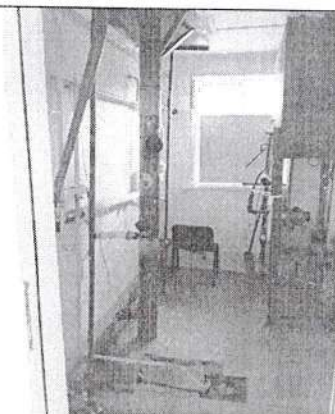
В котельной Луговской НОШ, Лугов- ского ФАП демонтирован котёл
