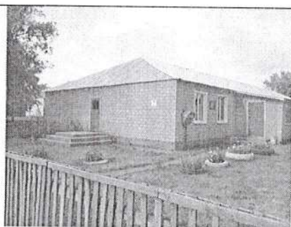
Техническое обследование Луговской НОШ, Луговского ФАП
